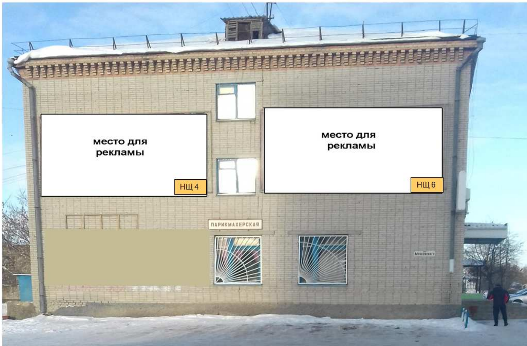
г.Далматово, ул.Энгельса д.17, фасад с южной стороны (настенный щит № 4,6)
